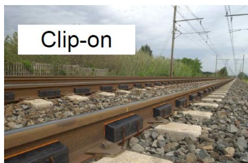
Figura nr 4: Amortizor de zgomot CORUS, aplicat
